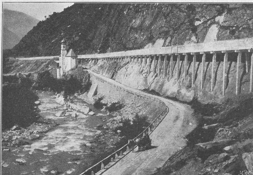
Abb. 11. Wasserkraftanlage. — Der Zuleitungskanal in armiertem Beton.
