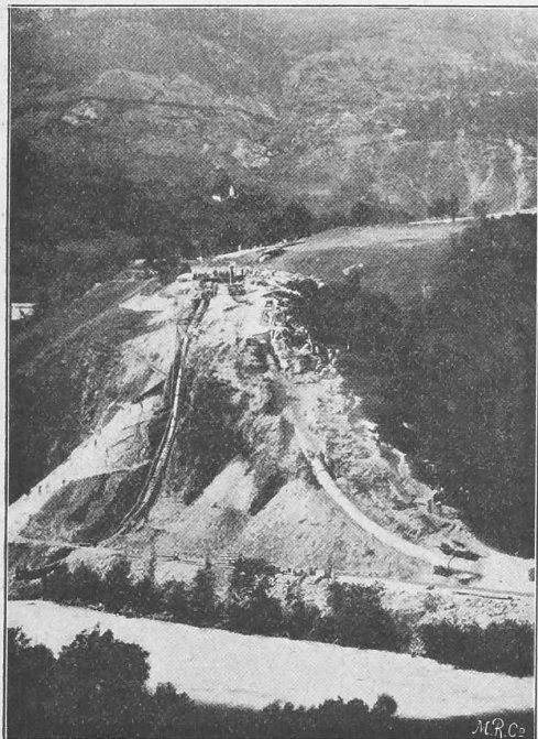
Abb. 17. Das Wasserschloss mit Druckleitung und Leerlauf während des Baues.
