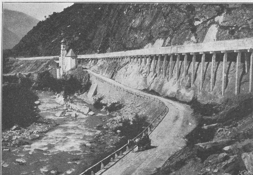
Abb. 11. Wasserkraftanlage. — Der Zuleitungskanal in armiertem Beton.
