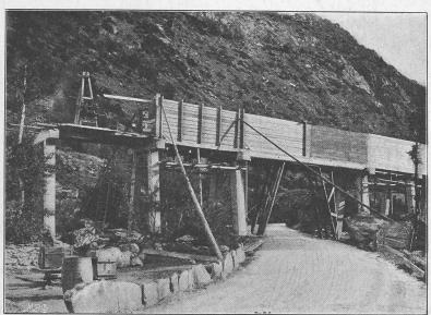
Columbiastroms. Von Abb. 8. Wasserkraftanlage. — Ueberführung des Oberwasserkanals über die Furkastrasse.
