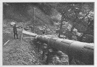
Abb. 8. Pendel mit Rohrpfeiler, oberhalb des Schilstobels.
