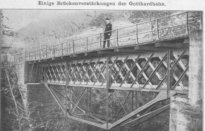
Fig. 18. Verstärkte Grotta-Brücke.
