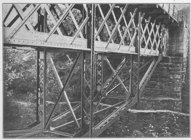
Fig. 11. Verstärkte Galli-Brücke.
