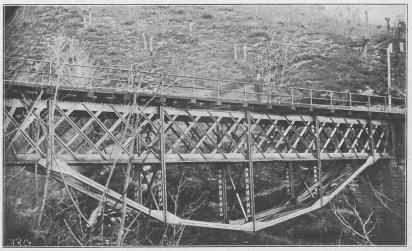
Fig. 10. Verstärkte Torino-Brücke.
