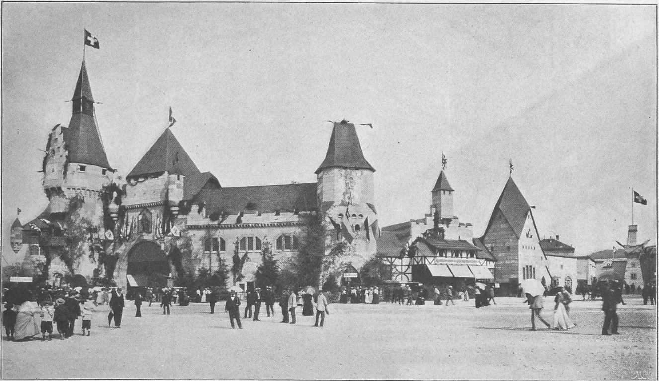
Abb. 2. Fassade der Festhütte gegen den Bahnhofplatz mit dem Haupteingang.
