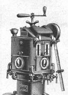
Keine zerstörenden Einflüsse der Bewegungsmechanismen durch Staub, Schmutz etc., weil mit vollständigem Schutzmantel und Getriebschutz versehen.
