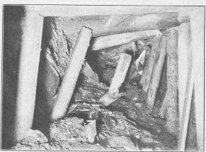
Fig. 4. Zerdrückter Voreinschnitts-Stollen des Jägerhaus-Tunnels am 1. August 1899.
