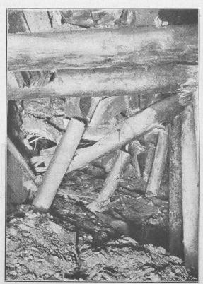
Fig. 5. Zerdrückter Voreinschnitts-Stollen des Jägerhaus-Tunnels 14 Tage nach Eintritt der Rutschung.
