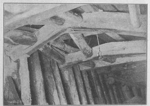
Fig. I. Sicherungseinbau an den zerdrückten Stellen des Neuländer-Tunnels.
