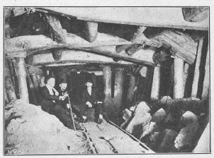
Fig. 2. Sicherungseinbau an den zerdrückten Stellen des Neuländer-Tunnels.
