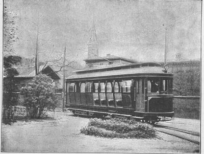
Fig. 2. Duplex-Wagen mit teils geöffneten, teils geschlossenen Abteilungen.
