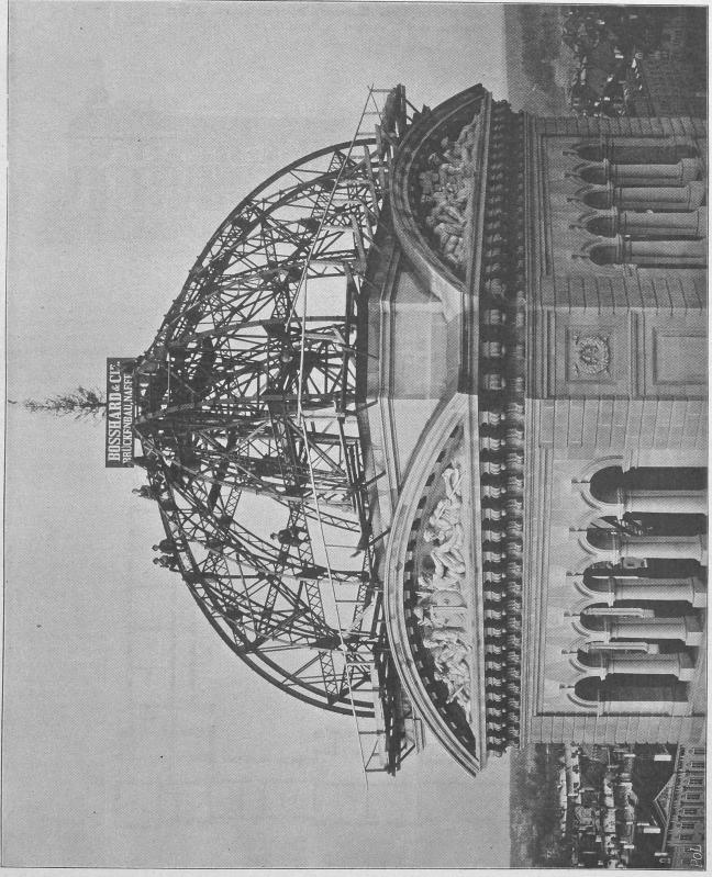
4. Die Kuppel während der Montage der Eisenkonstruktion
