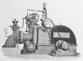
Fig. 39. 110 P.S. Hochdruckturbine für Arosa.
