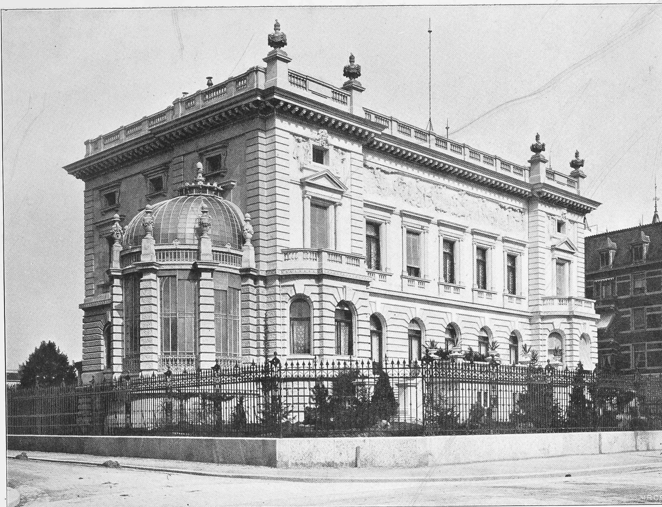
Galerie Henneberg am Alpen-Quai in Zürich.
