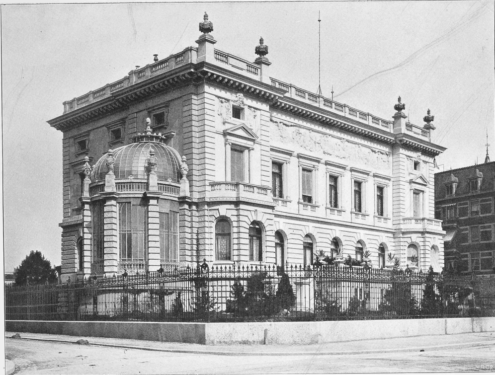
Galerie Henneberg am Alpen-Quai in Zürich.
