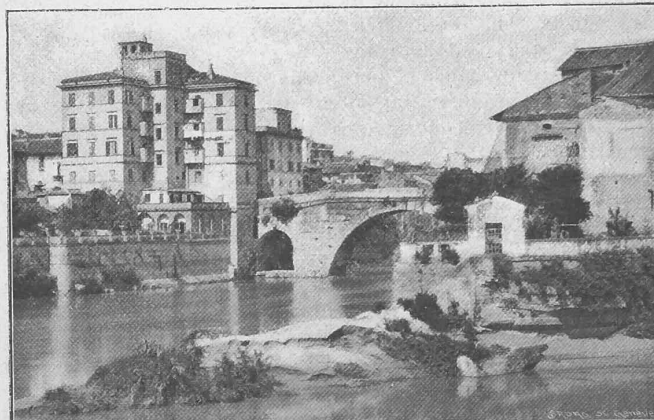
Fig. 2. Der Ponte Cestio. — Vor der Tiberregulierung.
