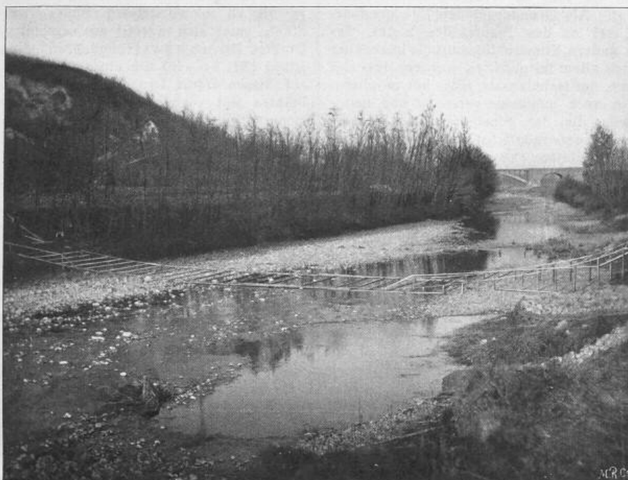
Fig. 1. Darstellung des bisherigen Trapezprofils und des neuen Ovalprofils durch Lattenfigur.
