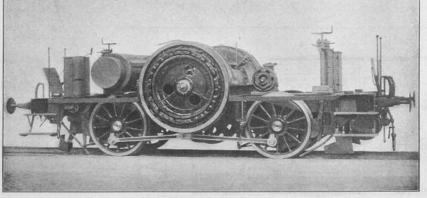
Fig. 33. Dreiphasen-Lokomotive (Kasten und Verschalungen abgehoben).
