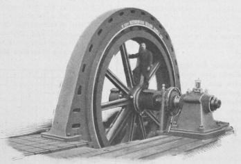
Fig. 1. Drehstromgenerator für 840 P.S.
