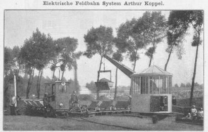
Fig. 1. Elektrische Bahn in Verbindung mit elektrischem Drehkran.
