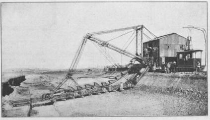
Fig. 2. Elektrischer Bagger und elektrische Lokomotive.
