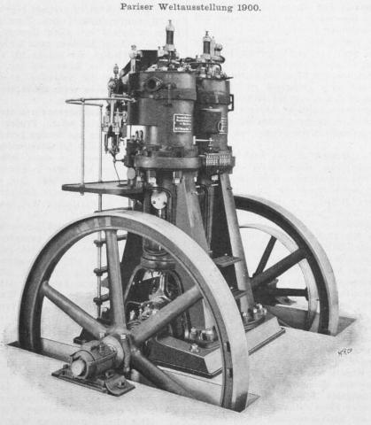
Fig. 12. Zwillings-Diesel-Motor von 60 P. S. Gebaut von der Maschinen-Fabrik Augsburg-Nürnberg.
