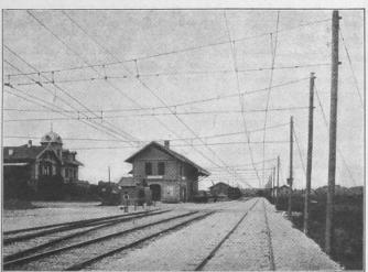
Fig. 19. Anordnung der Konktaktleitung auf einer Station mit drei Geleisen.
