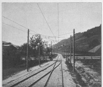
Fig. 23. Anordnung der Kontaktleitung in einer einfachen Weiche,
