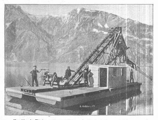
Maschine in Flüelen, mit verstellbarer Sortiereinrichtung.
