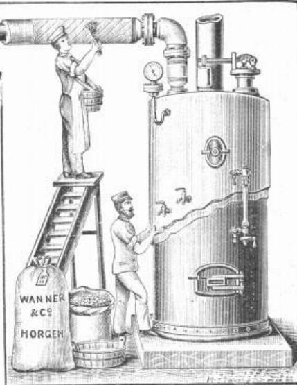
Komplete Isolierungen an Dampf- und Heizungs-Anlagen zum Schutze gegen Wärmeverlust, sowie an Wasserleitungen zum Schutze gegen Einfrieren führen wir fachgemäß, wirkungsvoll und prompt durch geübte Specialarbeiter aus. — Ausführlicher Katalog und Kostenvoranschläge gratis und franko.
