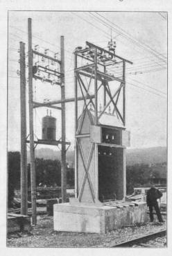
Fig. 8. Transformator-Station mit Notausschalter-Gestänge.
