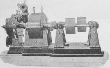
Fig. 6. Laval-Dampfturbine von 75 eff. P. S.
