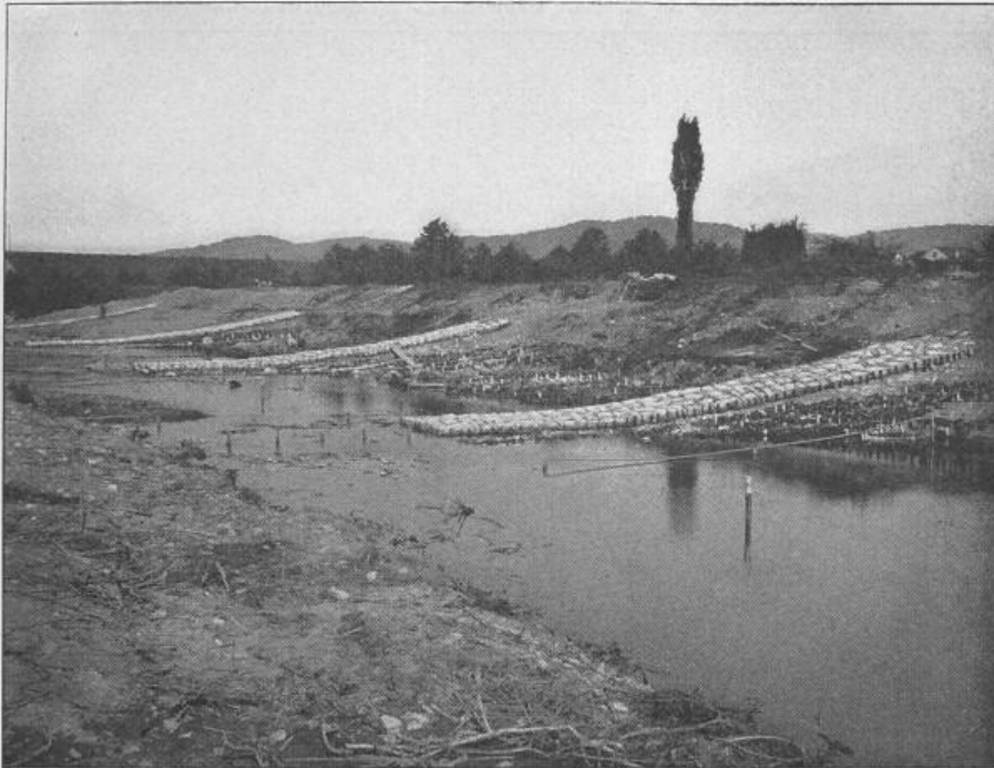
Fig. 7. Gürtel- und Unterbau der Zwischenfelder.
