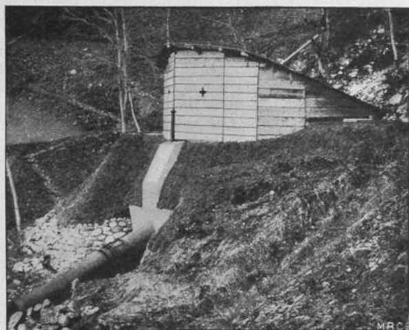
Fig. 6. Reservoir und oberste Expansionsvorrichtung der Druckleitung.
