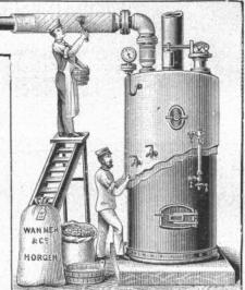
Komplete Isolierungen an Dampf- und Heizungs-Anlagen zum Schutze gegen Wärmeverlust, sowie an Wasserleitungen zum Schutze gegen Einfrieren führen wir fachgemäss, wirkungsvoll und prompt durch geübte Specialarbeiter aus. — Ausführlicher Katalog und Kostenvoranschläge gratis und franko.
