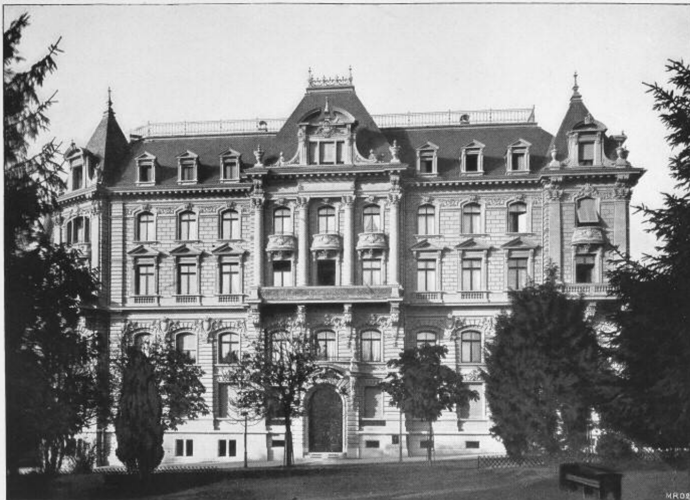
Verwaltungsgebäude der Schweizerischen Mobiliar-Versicherungs-Gesellschaft in Bern.
