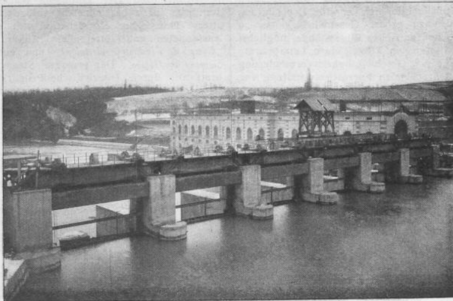
Fig. 2. Elektricitätswerk Chèvres bei Genf. — Wehranlage.
