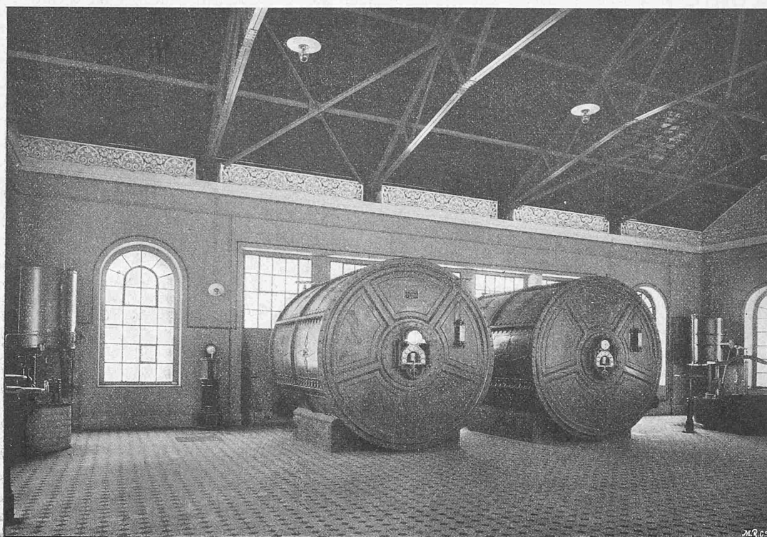
Fig. 28. Ansicht der Karburier- und Spiritus-Verdampfungs-Anlage.
