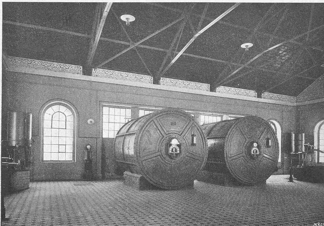
Fig. 28. Ansicht der Karburier- und Spiritus-Verdampfungs-Anlage.
