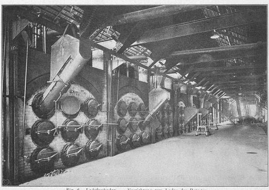
Fig. 6. Ladefussboden. - Vorrichtung zum Laden der Retorten.
