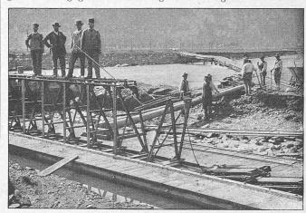
Fig. 10. Nadelwehr im Bau.
