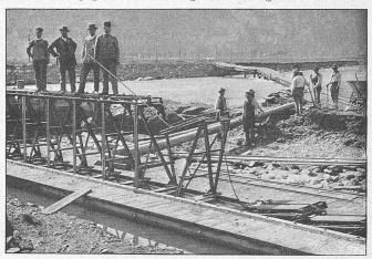
Fig. 10. Nadelwehr im Bau.
