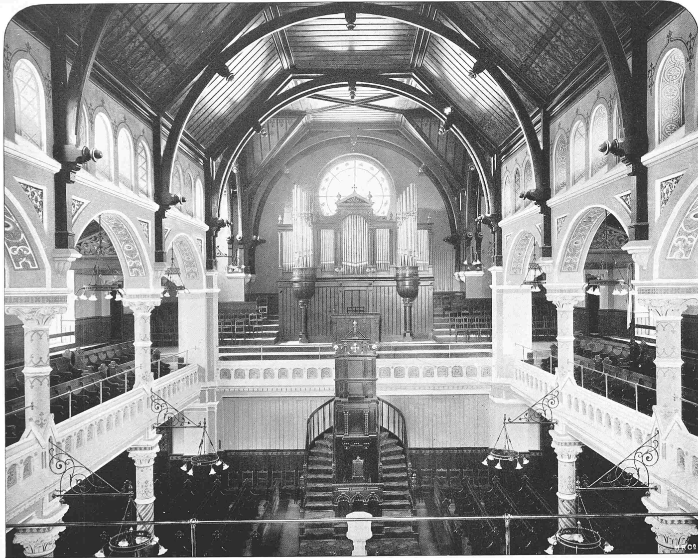
Innen-Ansicht der Johannes-Kirche in Aussersihl-Zürich (Industrie-Quartier).
