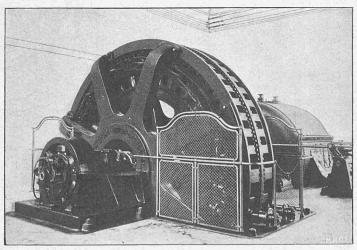
Fig. 13. Ansicht des Dreiphasen-Generators.
