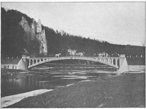
Fig. 37. Stampfbeton-Brücke über die Donau bei Inzigkofen.
