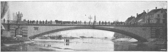
Fig. 38. Stampfbeton-Brücke über die Donau bei Munderkingen.
