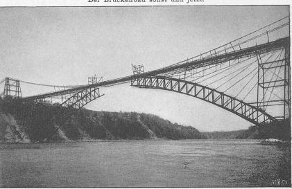
Fig. 28. Aufstellung der Niagara-Strassenbrücke bei Cliffton.
