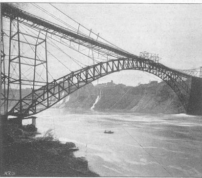
Fig. 29. Aufstellung der Niagara-Strassenbrücke bei Cliffton.
