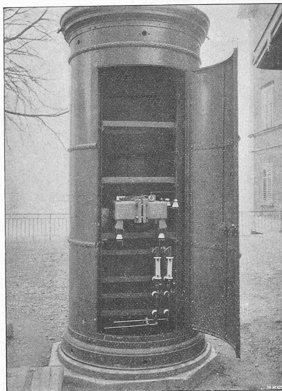
Fig. 16. Transformatorstation. — Ansicht der Primärseite.
