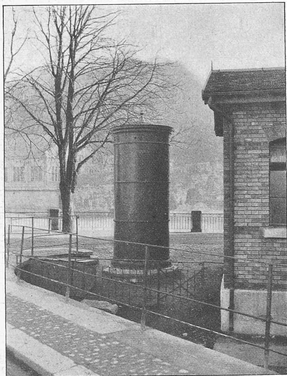
Fig. 14. Transformatorstation für unterirdische Primär- und Sekundärleitung.
