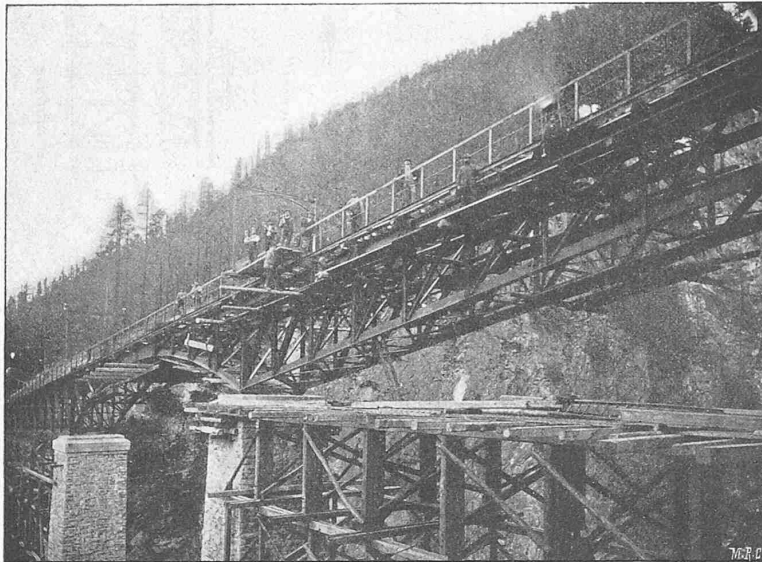
Fig. 13. Findelenbach-Brücke im Bau.
