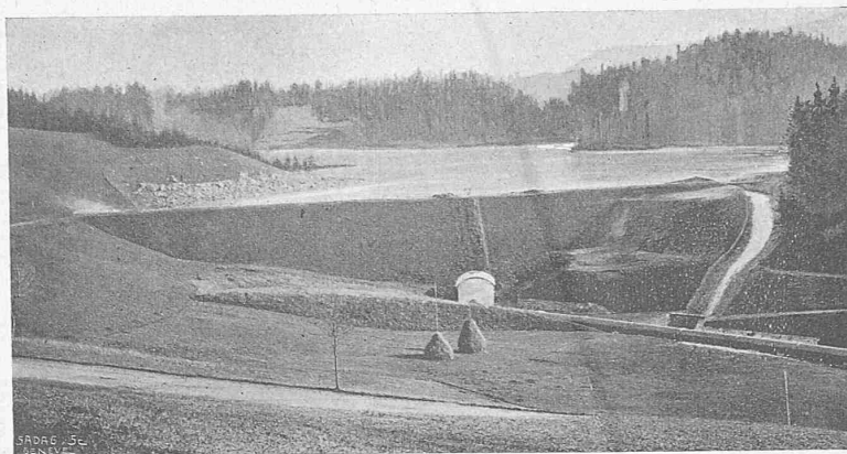
Fig. 21. Ansicht von Weiher und Damm mit Ueberlauf und Rohrleitung.
