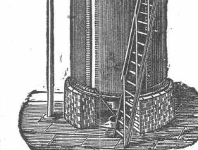
Schnellfilter mit Silex-Einlage, sich selbst reinigend, f. schmutzige Wässer.
