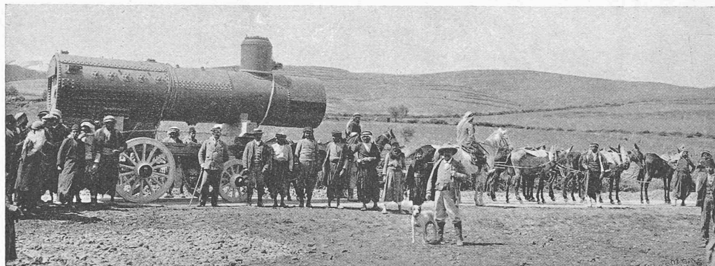
Fig. 23. Transport eines Lokomotiv-Kessels.
