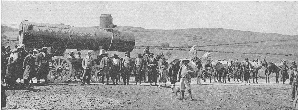
Fig. 23. Transport eines Lokomotiv-Kessels.
