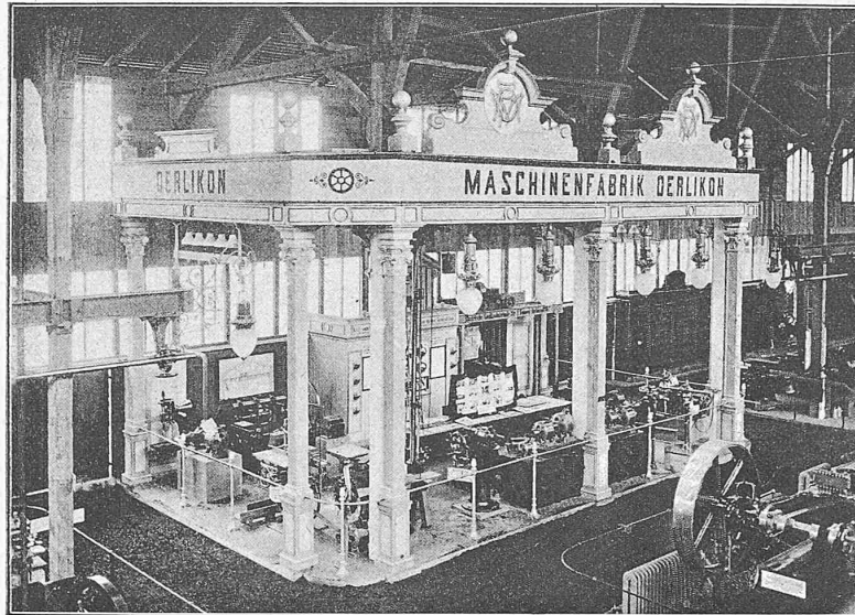
Fig. 1. Ausstellung der Maschinenfabrik Oerlikon in der Maschinenhalle.
