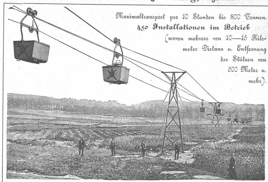
Diese Bahnen bieten das beste und vortheilhafteste Mittel für den Transport grösserer Quantitäten u. sind für jede Entfernung und für Steigungen bis zu 100% gebaut unter Garantie für guten Betrieb und solide Ausführung.
