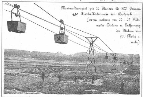
Diese Bahnen bieten das beste und vortheilhafteste Mittel für den Transport grösserer Quantitäten u. sind für jede Entfernung und für Steigungen bis zu 100 0/0 gebaut unter Garantie fiir guten Betrieb und solide Ausführung. \*
