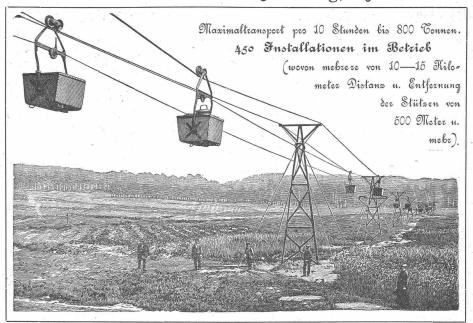
Diese Bahnen bieten das beste und vortheilhafteste Mittel für den Transport grösserer Quantitäten u. sind für jede Entfernung und für Steigungen bis  $zu 100^{0}/o$ gebaut unter Garantie fiir guten Betrieb und - solide Ausführung.
