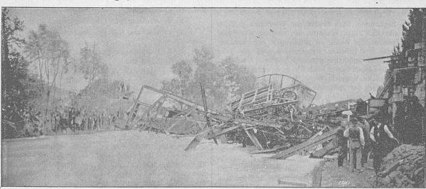
Fig. 4. Einsturz der Eisenbahnbrücke bei Mönchenstein.
