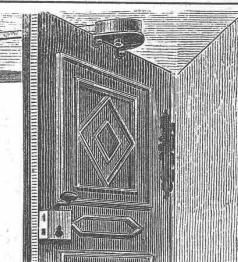
Dieses neue, elegante und praktische System, das allen andern bis jetzt gebräuchlichen Fabricaten an Zweckmässigkeit und Solidität weitaus überlegen ist, ermöglicht bei richtiger und leicht ausführbarer Regulirung ein ebenso unbedingtes als auch fast geräuschloses Schliessen der Thüren.
