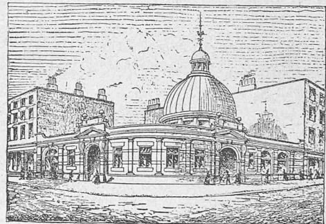
Empfangsgebäude der Station Borough-High-Street.
