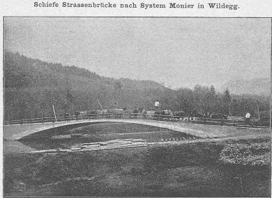
Spannweite  $l=37,22\ m$ ; Pfeilhöhe  $h=3,50\ m$ ; h:l=10,6; Scheitelstärke  $=20\ cm$ .
