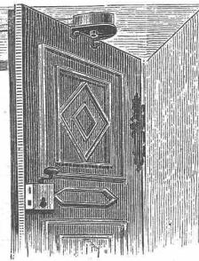
Dieses neue, elegante und praktische System, das allen andern bis jetzt gebräuchlichen Fabricaten an Zweckmässigkeit und Solidität weitaus überlegen ist, ermöglicht bei richtiger und leicht ausführbarer Regulirung ein ebenso unbedingtes als auch fast geräuschloses Schliessen der Thüren.
