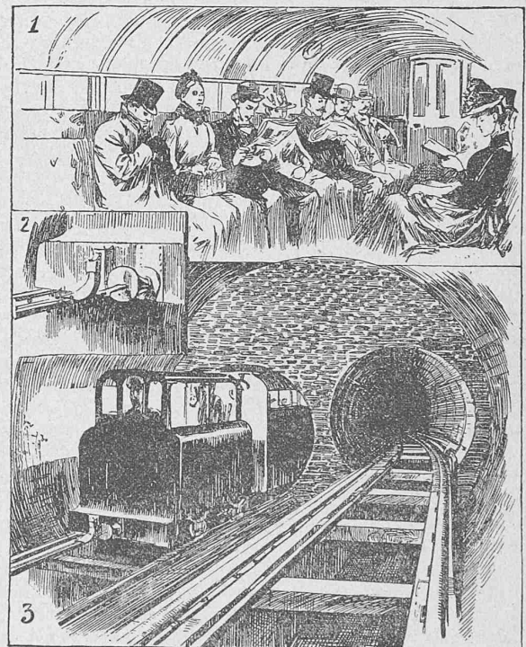
1. Inneres eines Personenwagens. 2. Verbindung der electriche Locomotiven mit der Leitung. 3. Mündung des Tunnels in eine unterirdische Station.
